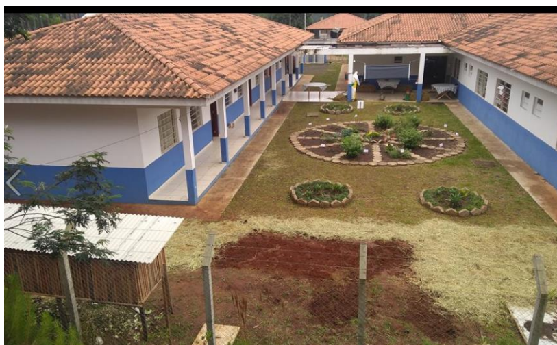
Figura 1. Estrutura externa da Casa Familiar Rural.
