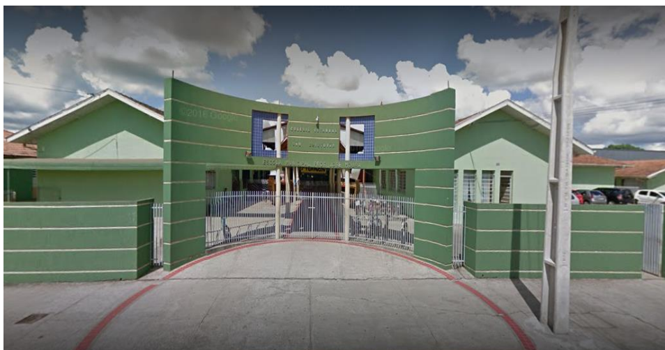
Figura 2. Estrutura externa do Colégio Estadual São Cristóvão.
